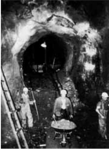
Mit einfachsten Werkzeugen bauten die Arbeiter damals Tunnel in das sehr harte Gestein. Schwere Maschinen waren auch wegen der Einsturzgefahr tabu. Beim unvorsichtigen Handtieren mit Sprengstoff gab es mehrere Unfälle. Der 1200 Meter lange Tunnel zwischen Buchbergmühle und Saußbach musste von den beiden Enden aus gegraben werden. Der genau berechnete Tunneldurchstich gelang nach mehrjähriger Bauzeit in der Mitte.
